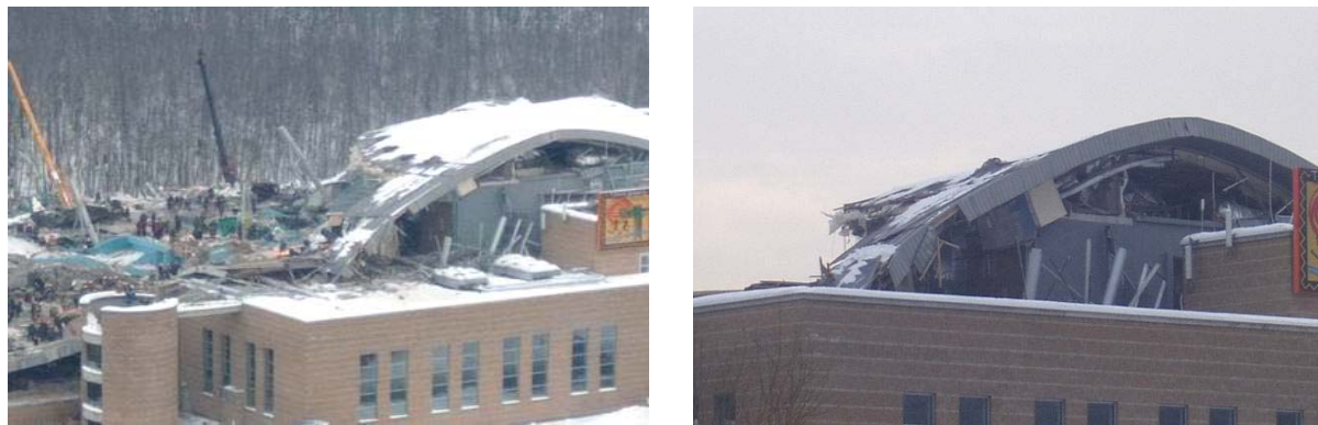
Рис.30. Обрушившееся здание Московского аквапарка
